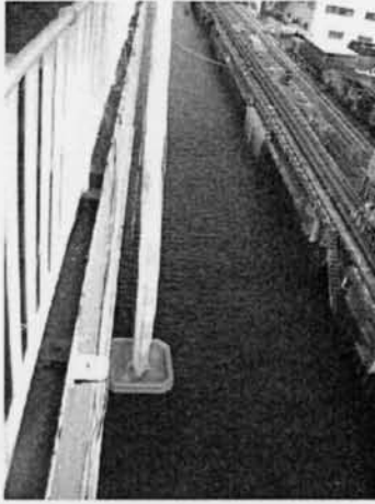
図9 スパイラル式シューターとプラットフォーム
